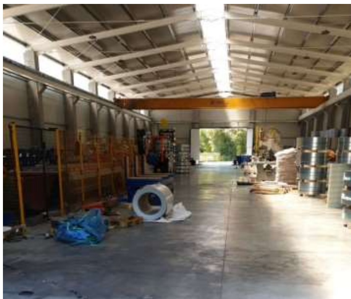
Figura 18: nuovo locale in allestimento.
